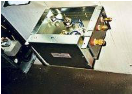
Boîtier de répartition (avec l'arrivée des 3 tubes)
